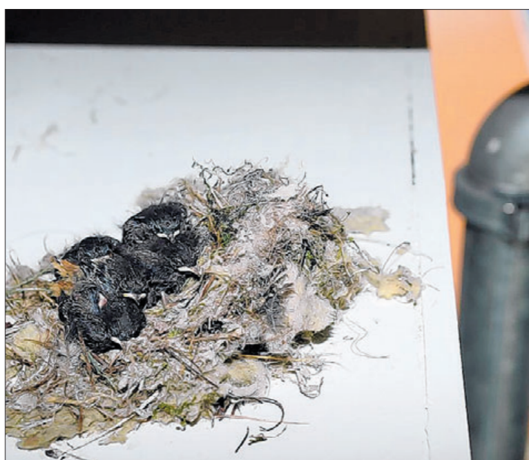
Piep-Show in der neuen EWS-Arena: Mitten auf der Baustelle wurde ein Nest mit Hausrotschwänzchen entdeckt. Foto: Giacinto Carlucci
